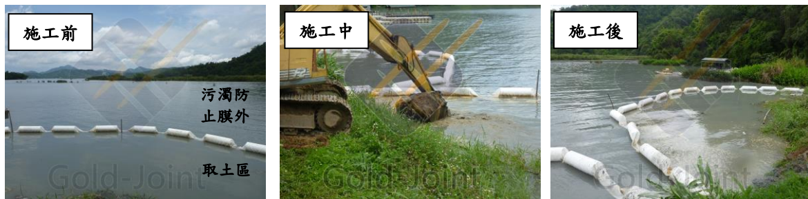
圖十一. 污濁防止膜具有明顯攔汙效果
