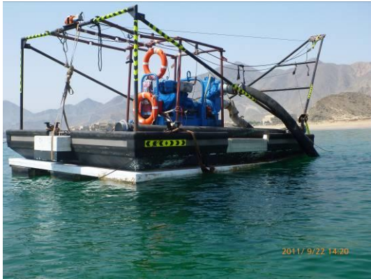
圖 11 施工用抽砂船
